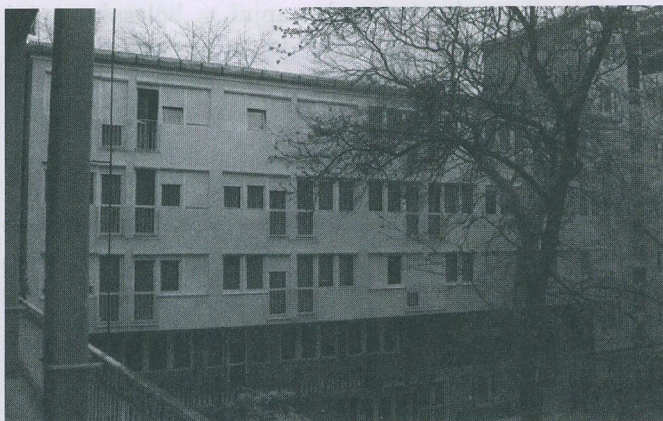
A Ráday utcai internátus felújított épülete
